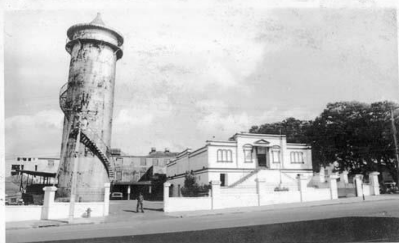
Figura 2- Comando do Corpo de Bombeiros Militar que funcionou em um prédio na Avenida Gomes de Castro, Praça Deodoro, na década de 1970.
